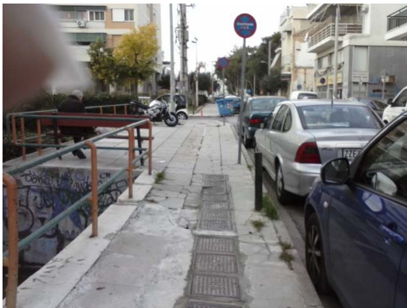
Πεζοδρόμιο επί της οδού Μαδύτου (από Ανδριανουπόλεως έως Τοσίτσα)
