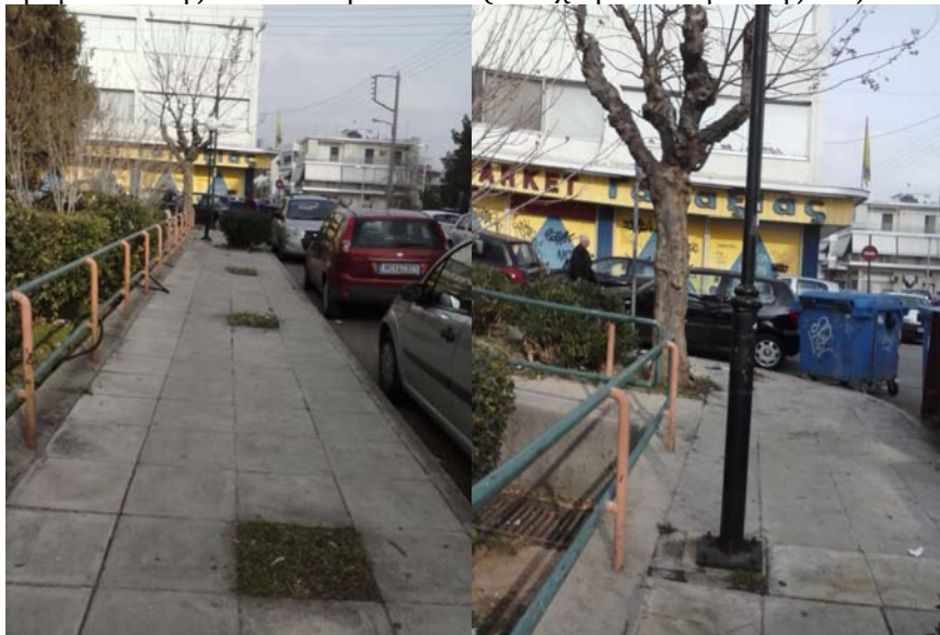
Πεζοδρόμιο επί της οδού Ελλησπόντου (από χώρο στάθμευσης έως Μαδύτου)
