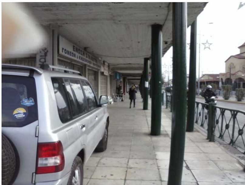
Πεζοδρόμιο επί της Λεωφ. Παναγή Τσαλδάρη (από Τοσίτσα έως Αισώπου)
