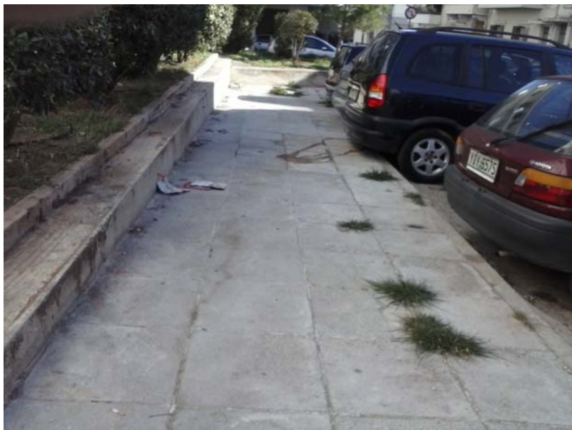
Πεζοδρόμιο επί της οδού Δρας (από Αισώπου έως Σάρδεων)
