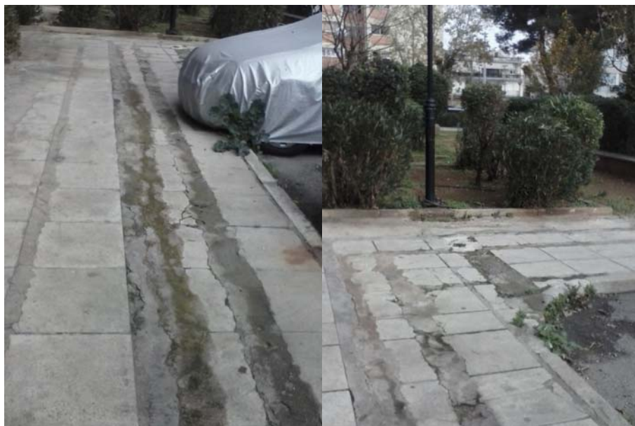
Πεζοδρόμιο στον χώρο στάθμευσης μπροστά από οδό Αισώπου
