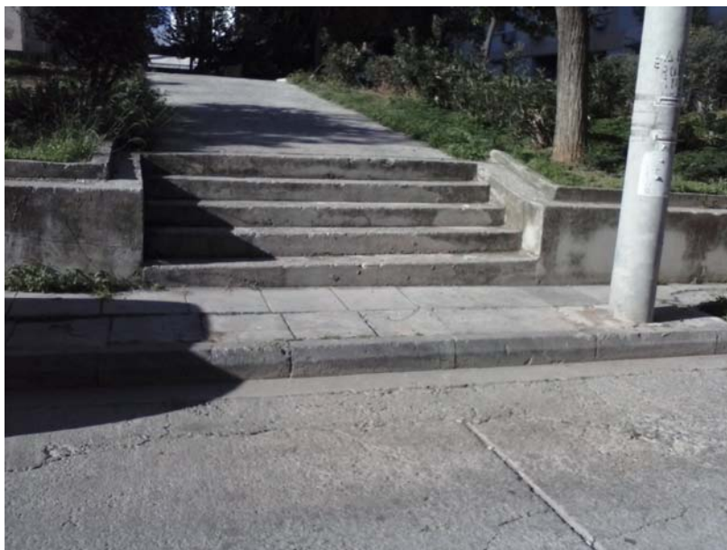
Επί της οδού Σάρδεων, είσοδος διάδρομος μπροστά πολυκατοικία 3
