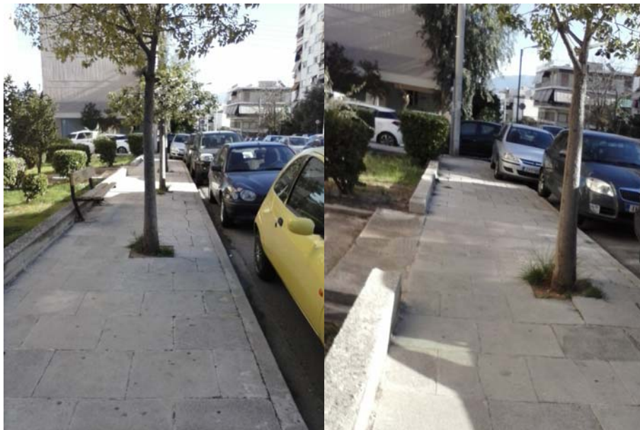
Πεζοδρόμιο επί της οδού Μαδύτου (από Ελλησπόντου έως Αισώπου)
