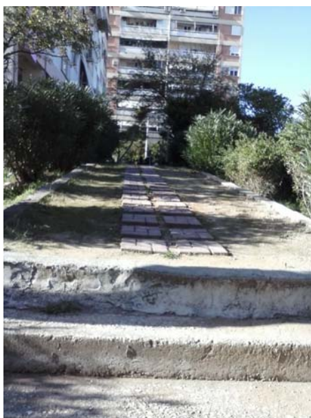
Επί της οδού Σάρδεων, είσοδος διάδρομος πολυκατοικίας 1
