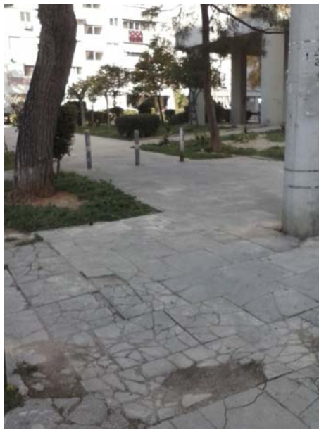
Εσωτερικός χώρος μπροστά από τις πολυκατοικίες 1-2-3
