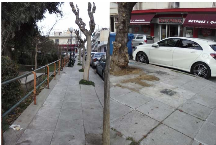
Πεζοδρόμιο επί της οδού Ανδριανουπόλεως (από χώρο στάθμευσης έως Μαδύτου)
