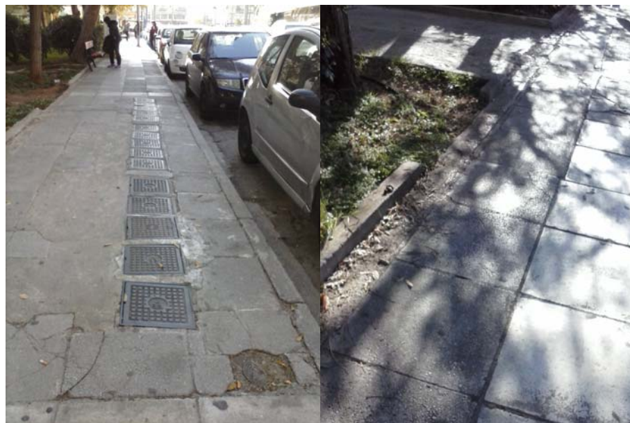
Πεζοδρόμιο επί της οδού Αισώπου (από Μαδύτου έως Δρας)
