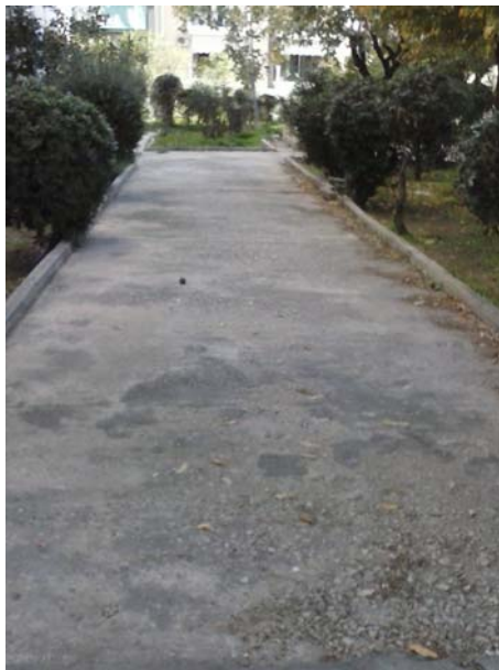
Επί της οδού Αισώπου, διάδρομος πολυκατοικίας 1
