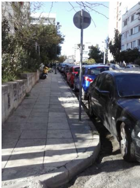
Πεζοδρόμιο επί της οδού Μαδύτου (από Σάρδεων έως Αισώπου)
