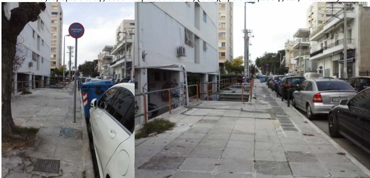
Πεζοδρόμιο επί της οδού Μαδύτου (από Ανδριανουπόλεως έως Τοσίτσα)
