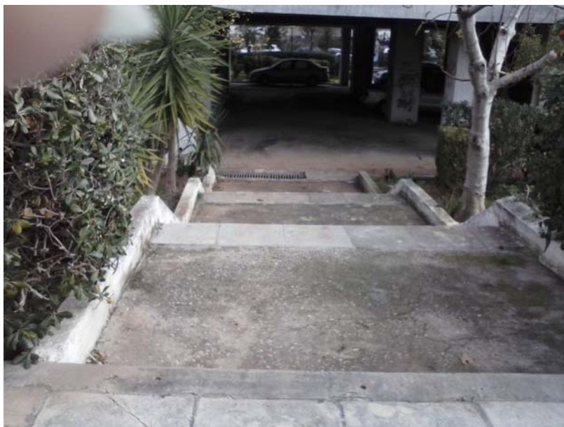
Επί της οδού Τοσίτσα, διάδρομος εισόδου πολυκατοικίας 1
