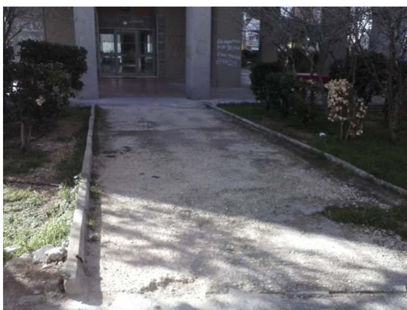
Επί της οδού Ορφέως, διάδρομος εισόδου προς πολυκατοικία 1
