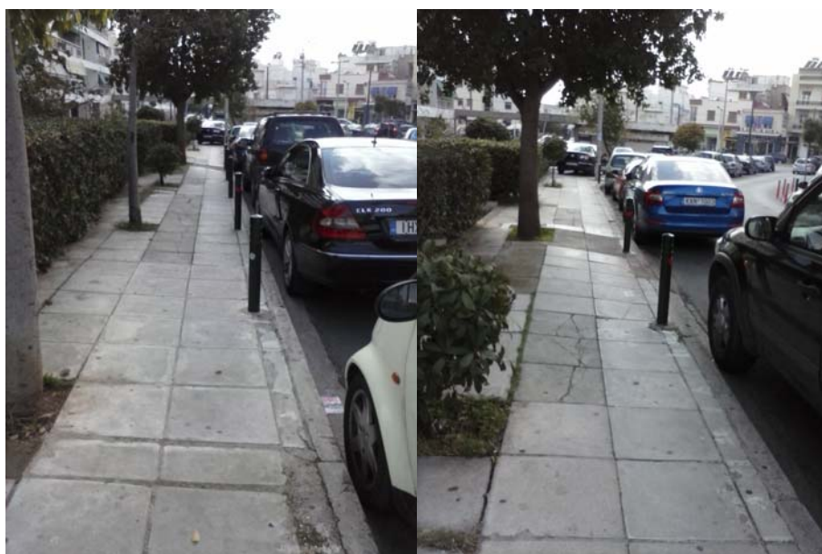
Πεζοδρόμιο επί της οδού Τοσίτσα (από Μαδύτου έως Παναγή Τσαλδάρη)
