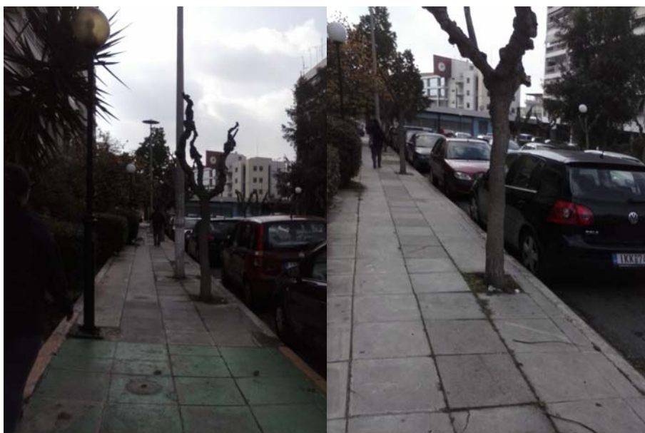
Πεζοδρόμιο επί της οδού Ανδριανουπόλεως (Από Μαδύτου έως χώρο στάθμευσης)
