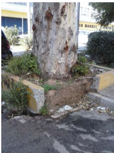
Πεζοδρόμιο επί της οδού Μαδύτου (από Ελλησπόντου έως Αισώπου)
